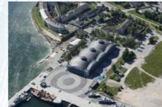
2. Musée maritime, reconversion d'anciens hangars à hydravions Arch. KOKO
