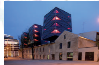
3. Ancien atelier de charpente Arch. KOKO
