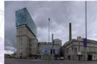
1. Fahle House, ancienne usine à papier Arch. KOKO
