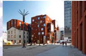
2. Ancienne minoterie Arch. HGA
