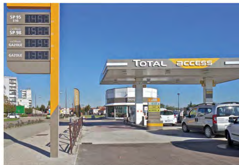
La station service de Jean Prouvé est un exemple emblématique de «patrimoine invisible»: nombre de ses clients ignorent certainement qu'elle a été réalisée par un célèbre constructeur.
