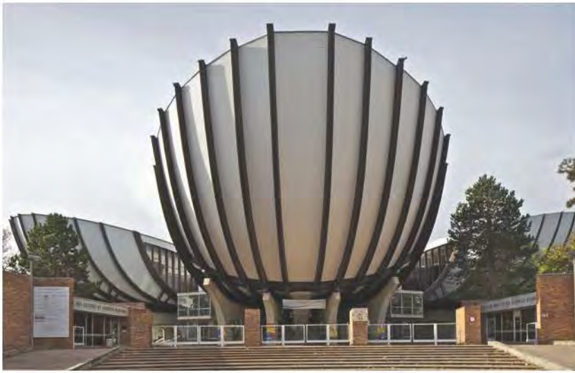
Les amphithéâtres de la faculté de lettres marquent l'entrée du campus.
