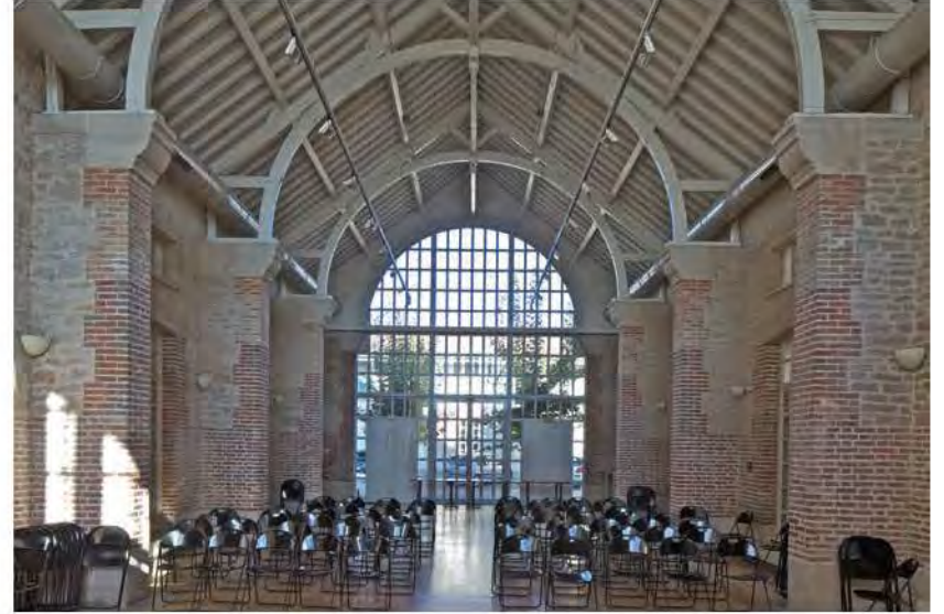
La halle abrite désormais une salle de conférence; l'unité de son ample volume couvert par une charpente inspirée de Philibert de l'Orme est ainsi mise en valeur.
