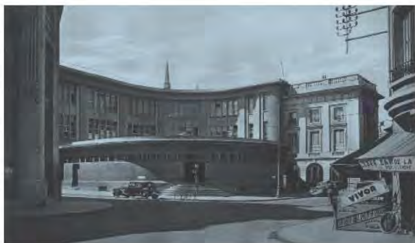
Cette vue datant probablement des années 1930 montre le rapport entre l'Hôtel des Postes et les édifices de la Place Royale.
