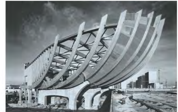
Photographie du chantier de réalisation d'un amphithéâtre de 600 places, montrant la structure en bois lamellé-collé.
