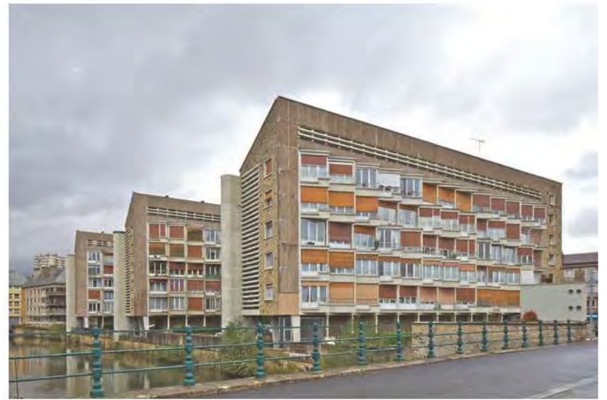
Immeubles de logements collectifs «les Peignes».
