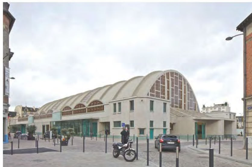
Le bâtiment, très dégradé, a fait l'objet d'une restauration soignée à l'intérieur comme à l'extérieur.
