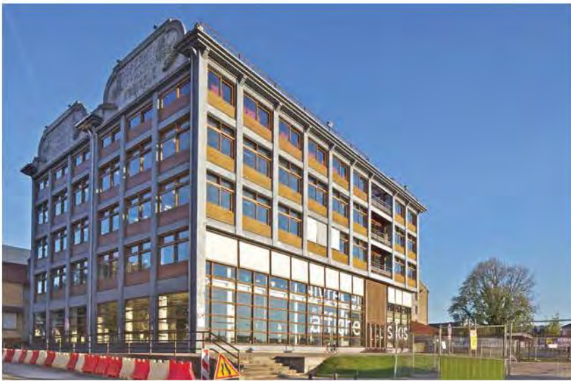
La réhabilitation a respecté les volumes originaux des deux silos accolés.
