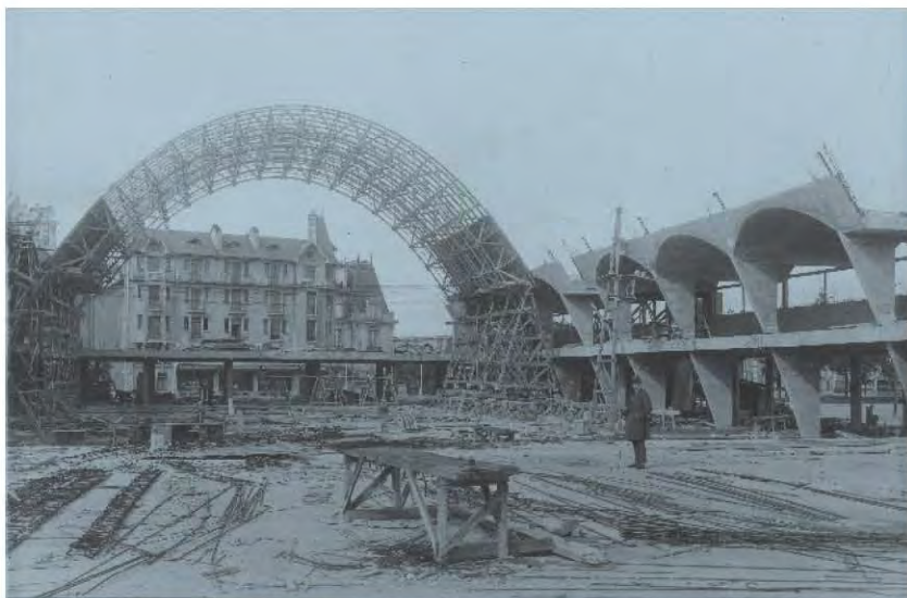
Vue du chantier et des cintres utilisés pour la construction de la voûte, vers 1927-1928.
