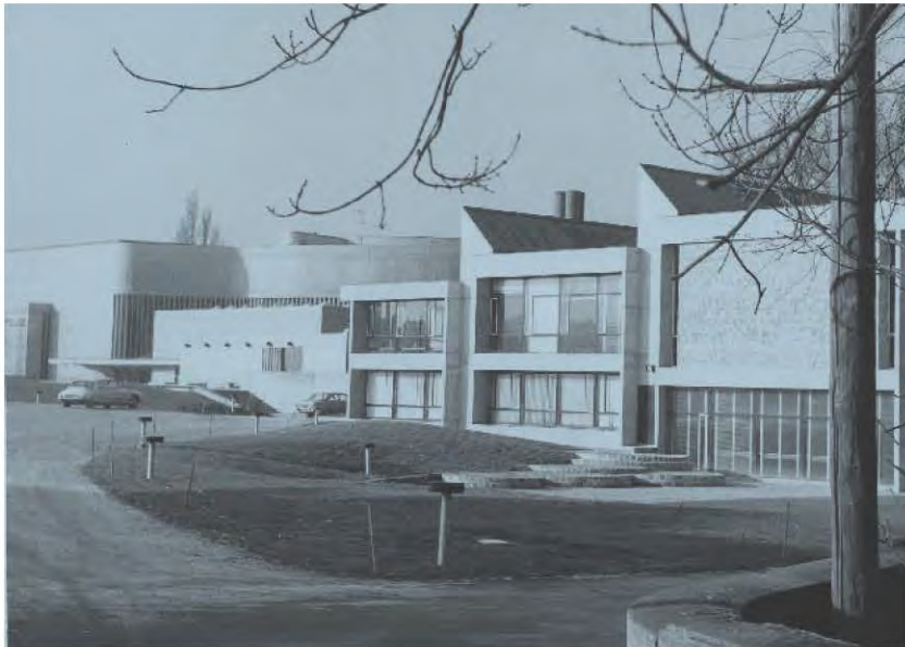
Certains espaces du bâtiment bénéficient d'un éclairage zénithal grâce à des sheds.
