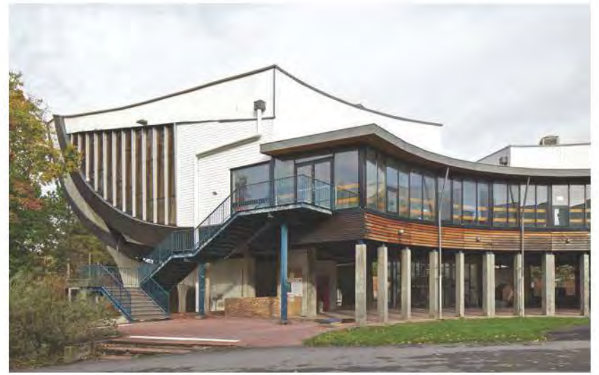
Vue de la galerie desservant les amphithéâtres.
