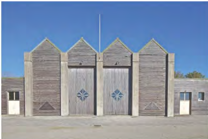
Vue des hangars destinés à abriter les bateaux.
