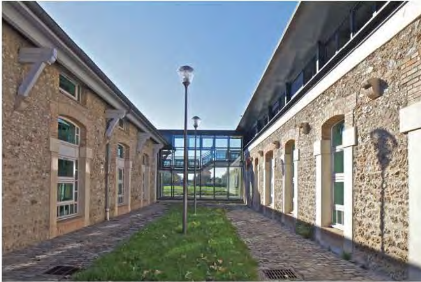
À l'issue de l'ensemble des interventions sur le site, édifices anciens et extensions contemporaines restent clairement différenciables.
