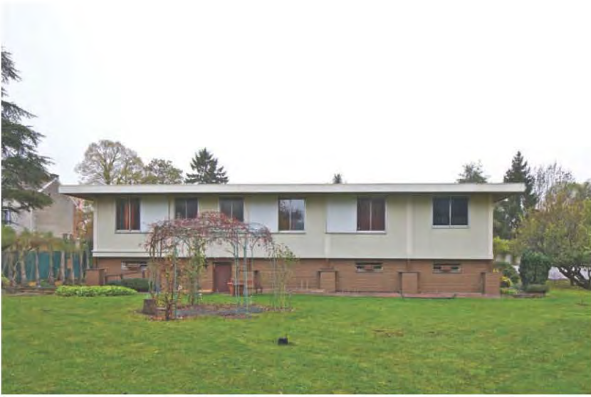
Façade arrière de la maison ; la structure en acier du volume principal repose sur un soubassement maçonneré.
