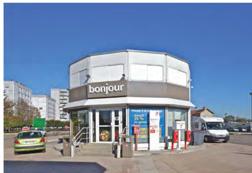
Ce petit volume est construit grâce à un nombre restreint d'éléments métalliques préfabriqués.
