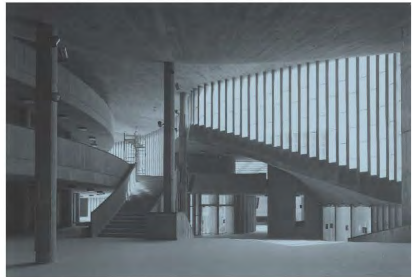
Vue intérieure du hall d'entrée. Un soin particulier a été accordé au coffrage du béton laissé brut dans tout le bâtiment, en particulier dans le hall, traversé de coursives massives d'une grande expressivité plastique.
