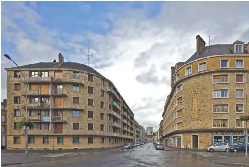
Vue des immeubles ayant reconstruit le centre-ville de Sedan, Jean de Mailly a utilisé à la fois le béton armé et la pierre, entre historicisme et modernité.
