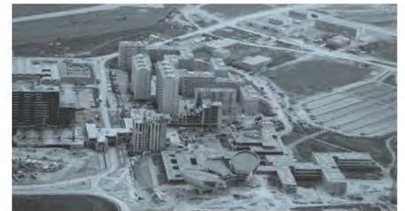
Photographie de l'ensemble du chantier de la ZUP durant la construction des amphithéâtres.
