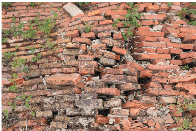
Les tuiles du château effondré de la Villeaux-Bois, avant d'être en partie déplacées à Morvilliers pour construire l'arche, mai 2022. Photo : EB.
