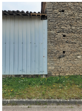
Détail d'un mur en pierres et tôle. Amance, avril 2022. Photo : EB.
