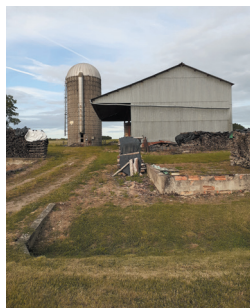
Hangar et silo à grain. Juzanvigny, mai 2022. Photo : ADH.
