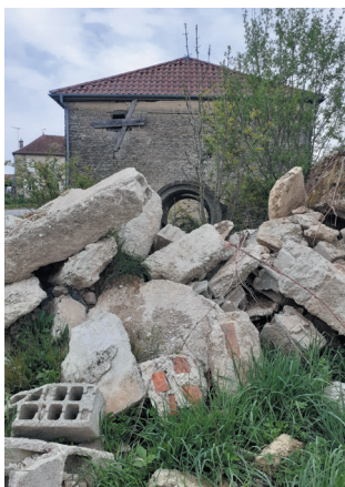
Sur le même terrain à l'abandon, un amas de pierres de taille et de parpaing raconte qu'ici devait se trouver une structure habitable. Photo : ADH.
